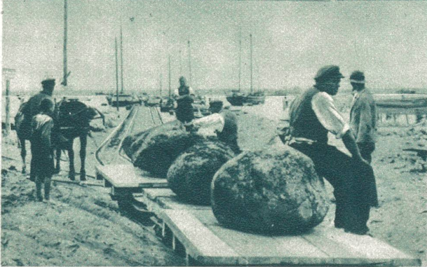
Steinfischer der Ostsee. Um die sandige Küste in Ostpreussen vor dem Zerbruchwerk des Meeres zu retten, werden grosse Molen-Befestigungen angelegt. Da das Land steinarm ist, so entstand die Gilde der Steinfischer, welche die Kolosse aus dem Meeresgrund heraufholen. Hier wird eine Mole gebaut und auf Feldbahnwagen die von den Steinfischern gemachte Beute zur Baustelle gefahren.
