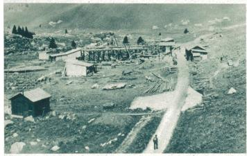
Vom Bau der Säntisbahn: Blick auf den heutigen Stand der Bauarbeiten auf der Schwägalp. In der Mitte das Gerüst der Schwebehahn für den Materialtransport von der Schwägalp auf den Säntisgipfel. Eine moderne Verkehrsstrasse ins Tal hinunter ist ehenfalls im Bau.
