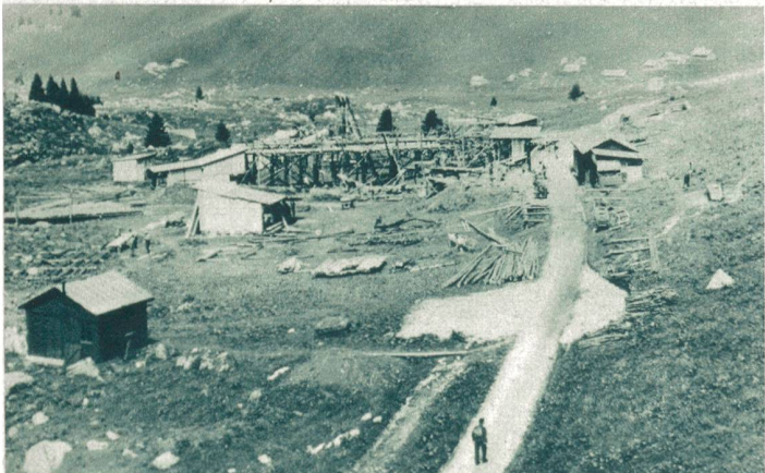
Vom Bau der Säntisbahn: Blick auf den heutigen Stand der Bauarbeiten auf der Schwälgalp. In der Mitte das Gerüst der Schwebbahn für den Materialtransport von der Schwälgalp auf den Säntisgipfel. Eine moderne Verkehrsstrasse ins Tal hinunter ist ebenfalls im Bau.
