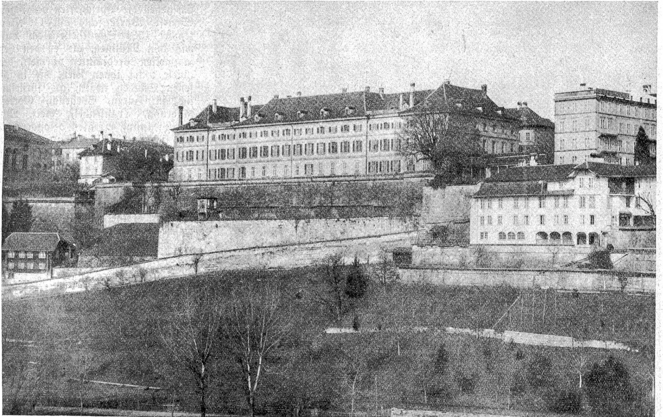
Die alte Insel in Bern, erbaut 1718—24 nach Plänen von Bär von Werkmeister Dünz, wurde 1888 abgebrochen, um dem Bundeshaus-Ostbau Platz zu machen.
