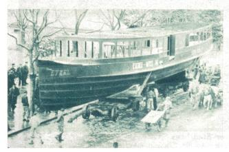
Links: Ein origineller Schiffstransport. Ein in den Werkstätten der Firma Escher-Wyß gebautes Passagierschiff für den Zürichsee wurde auf Rädern von der Werkstätte nach dem See gebracht. Unser Bild zeigt den Passagier-Photogress. dampfer »Etzel« beim Transport durch die Straßen Zürichs.
