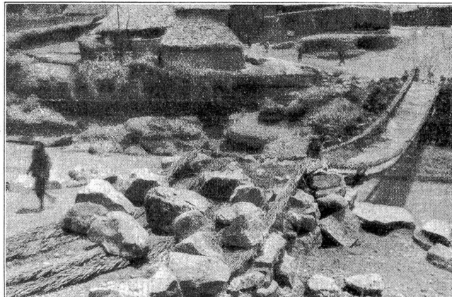
Eine andere Schwebebrücke. — Sie ist aus Pflanzen- und Wurzelfasern errichtet und unter Felsblöcken verankert.
