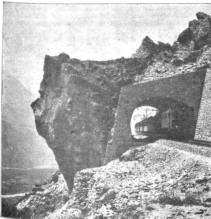
Viktoria Tunnel auf der Südrampe.
