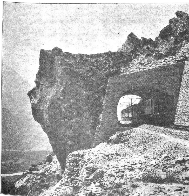
Viktoria Tunnel auf der Südrampe.
