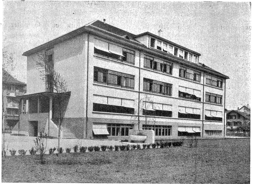
Das neue Uebungsschulhaus beim Oberseminar in Bern.
