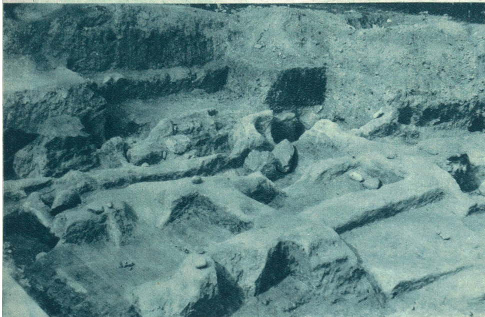
Interessante Ausgrabungen in Lyß (Kanton Bern). Auf dem Kirchhubel in Lyß wurde ein römisches Fundament bloßgelegt, sowie verschiedene alemannische Grufthen mit teilweise wertvollem Fundmaterial, welches dem Historischen Museum in Bern einverleibt wird. Photopress, Zürich.
