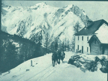
Schutzhaus an der Simplonstrabe.
