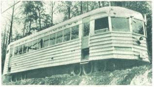
Der erste Schnellbahnwagen mit Gummibereifung in Philadelphia (Amerika). Dieser Wagen ist mit einem Sechszylinder-Viertakt-Dieselmotor von 125 PS. ausgestattet und entwickelt eine Durch-
