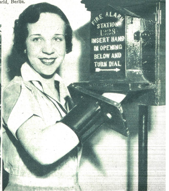
Unten rechts: Wer Feuer meldet, wird gefangen. Feuermelde-Apparat, der die Hand des Meldenden festhält, bis die Feuerwehr eintrifft. Dadurch sollen die vielen Falschmeldungen verhindert werden, denn derjenige, der die Feuerwehr umsonst bemüht, kann nicht entkommen.
