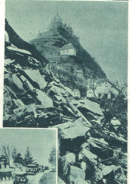
Der sinkende Berg bei Cochem. Der schon seit zwei Jahren sinkende Berg bei Cochem an der Mosel stürzt wöchentlich weiter um etwa 15 cm in sich zusammen. Täglich lösen sich schwere Gesteinsmassen und stürzen in die Tiefe.
