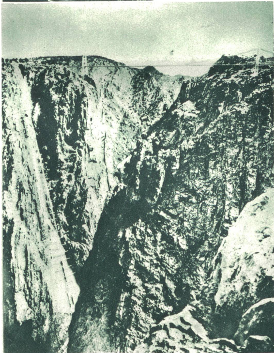
Die höchste Brücke der Welt — über den Arkansas River, im Staate Colorado, U. S. A. — ist dem Verkehr übergeben worden. Die Brücke, die 375 Meter über dem Spiegel des Flusses liegt, und deren Spannung zwischen den beiden Hauptpfeilern 295 Meter beträgt, sieht in der riesigen Felsenlandschaft wie ein feines Gewebe aus, sie trägt aber den Verkehr einer zweigleisigen Bahnlinie.
