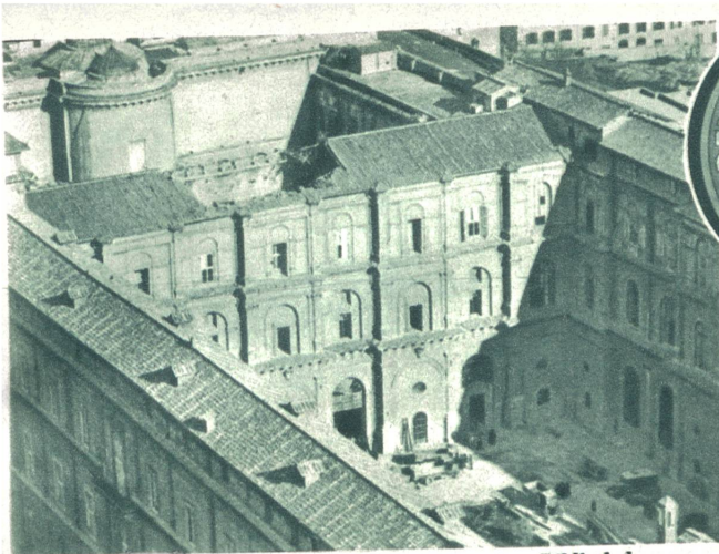
Die Einsturzkatastrophe in der Vatikanischen Bibliothek. Blick auf den Querbau im Vatikan, der vom Dach bis auf den Erdboden durchschlagen wurde.
