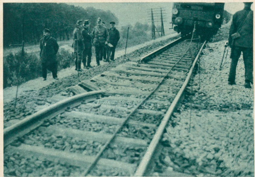
Vom Attentat auf den D-Zug Basel—Berlin bei Jüterbog. Der durch Explosion eines Sprengkörpers zerrissene Schienenteil, der die Entgleisung des Zuges verursachte.
