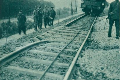
Vom Attentat auf den D-Zug Basel-Berlin bei Jüterbog. Der durch Explosion eines Sprengkörpers zerrissene Schienen-teil, der die Entgleisung des Zuges verursachte.
