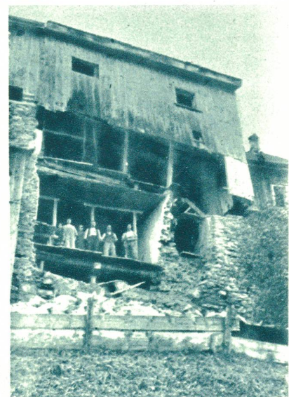
Unten: Mauereinsturz im Städtchen Werdenberg. Die eingestürzte Mauer bildete mutmaßlich einen Teil der ehemaligen Stadtmauer des historischen Städtchens Werdenberg (St. Gallen) und diente als Stütze der Ostfront des darüberstehenden Hauses.
