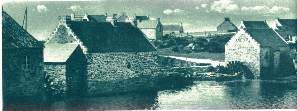
Aus der malerischen Bretagne: Alte Mühle bei Etel in der Landschaft Morbihan. Der Antrieb erfolgt durch das Meer, wenn es sich bei der Ebbe zurückzieht. Die schlichten Gebäude verraten in aller Einfachheit einen sympathischen Stil.
