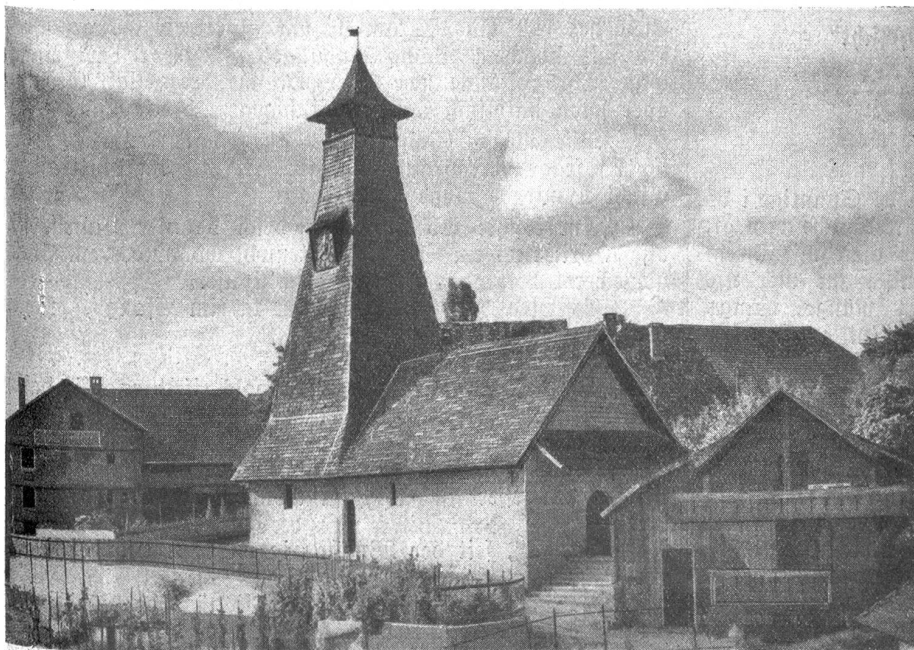
Das alte Dorfkirchlein in Schwarzenburg (1463); erneuert 1913.
