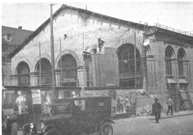
Der Abbruch des obern Teiles der Bahnhofhalle.
