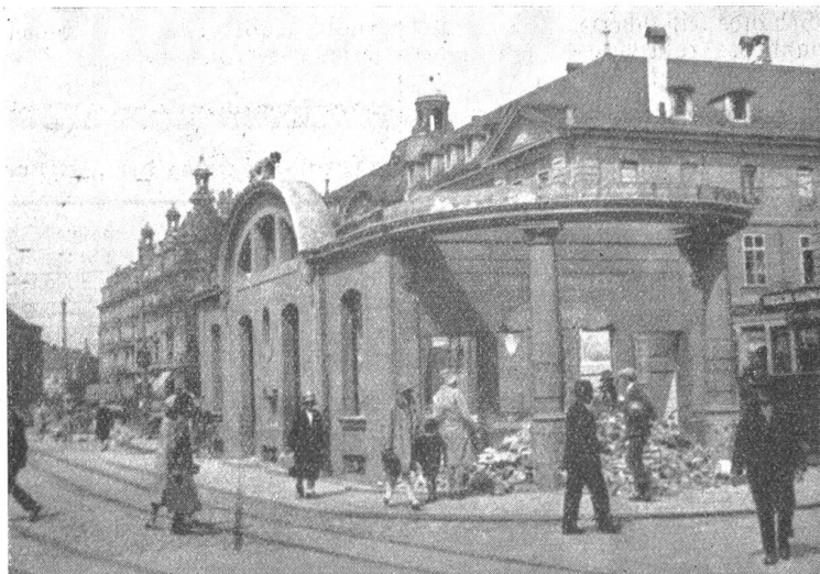
Der Abbruch des Tramhauses auf dem Bubenbergplatz.
