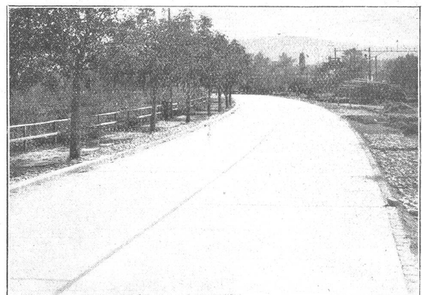
Betonbelag auf der Bahnhofstraße in Arbon, erstellt 1928.
