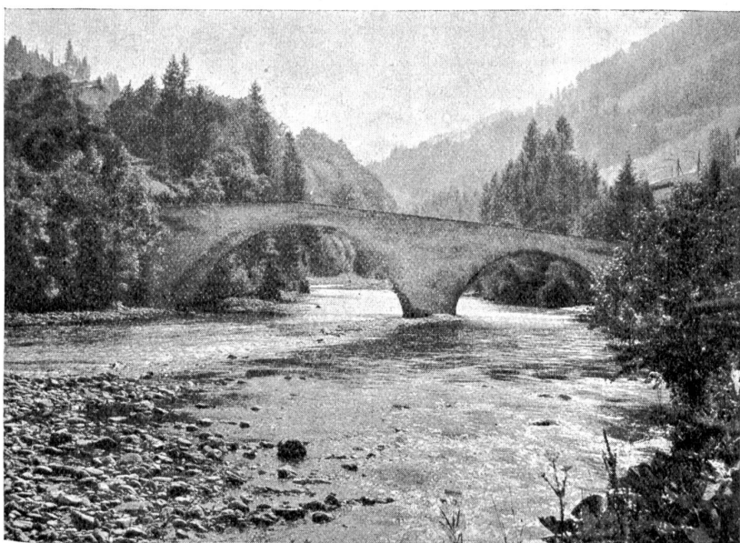
Abb. 4. Alte Steinbrücke über die Saane, Kanton Sriburg. Verschieden große Öffnungen, den Gründungsverhältnissen angepaßt, der Scheitel über dem höhern Bogen.
