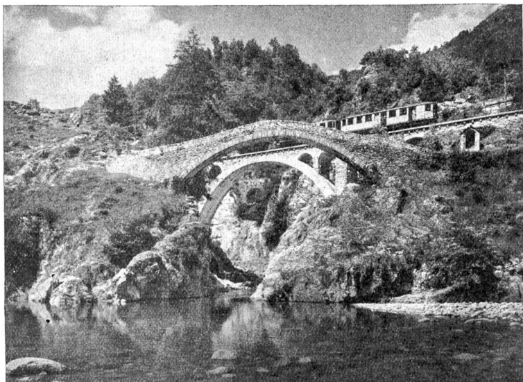
Abb. 1. Brücken im Centovalli, Tessin. Vorn eine alte Steinbrücke mit beidseitig ansteigender Sahrabahn; hinten die neue Eisenbahnbrücke mit Betongewölbe und Aufbauten mit Mauerwerkverkleidung.
