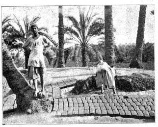
Mischlammziegelei bei Memphis. Trodnen der Ziegel an der Sonne, Als Bindemittel bei Ziegelbauten dient wiederum Milschlamm.
