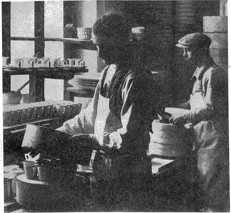
Verpacken der Tassen in feuerfeste Kapseln.
