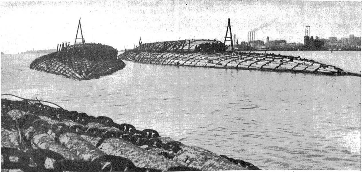
Riesensflöße in San Diego (Kalifornien) von 250 m Länge und 16 m Breite, die mit 175 Connen Stahlketten zusammengehalten werden.
