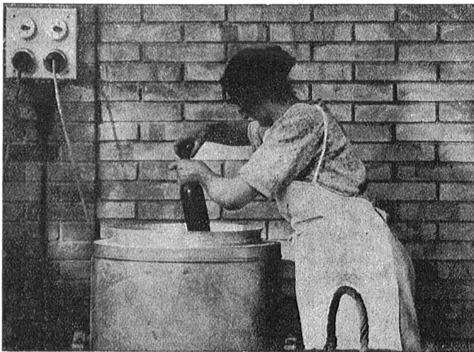
Der elektrische Futterkocher kann auch zum Sterilisieren benutzt werden.
