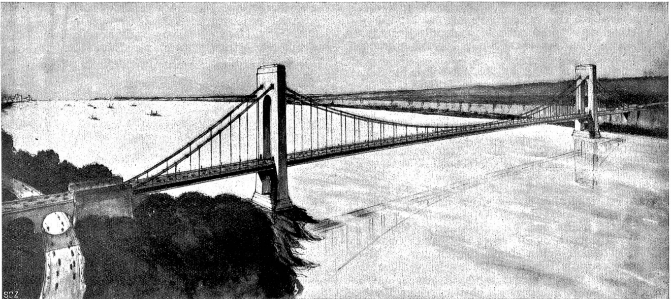
Die vom Schweizer Ingenieur O. B. Ammann in New York projektierte Riesenhängebrücke über den Hudson-River. (Spannweite 1036 m, Höhe der 33 m breiten Brücke über dem Wasserpiegel 64 m, der Pfeiler 210 m, Kosten 35 Millionen Dollars.)
