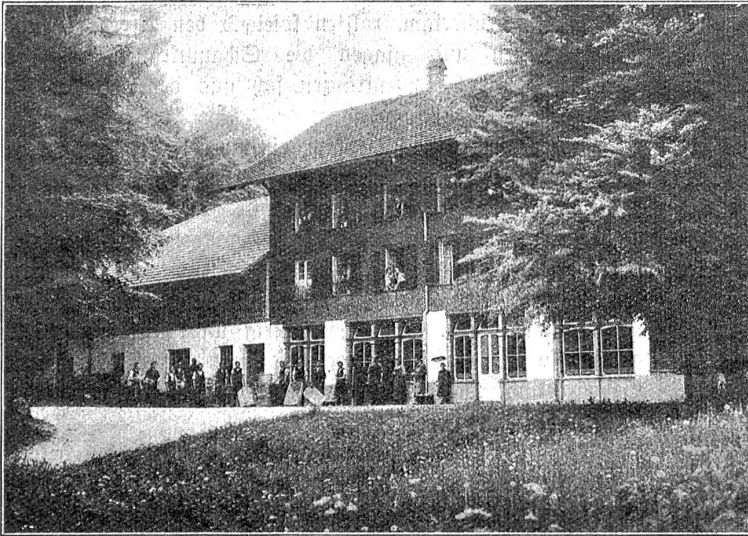
Blindenanstalt Spiez. Werkstattgebäude.
