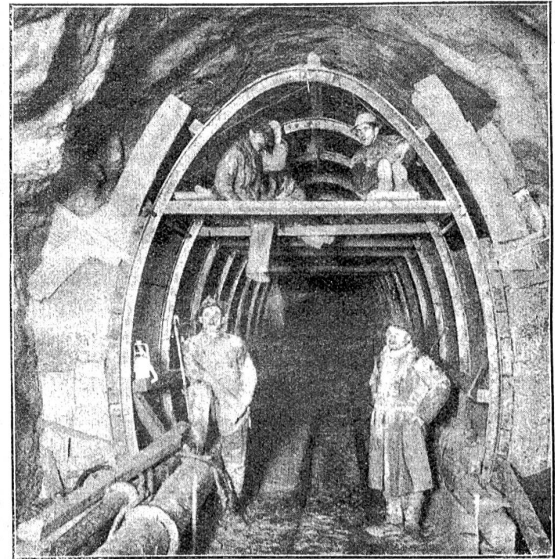
Sulgenbach-Stollen bei km 654. Eiserner Schablonen tragen die hölzerne Einfallung, hinter welcher der Beton eingebracht wird. Widerlager bereits erstellt. (6. Nov. 1922.)
