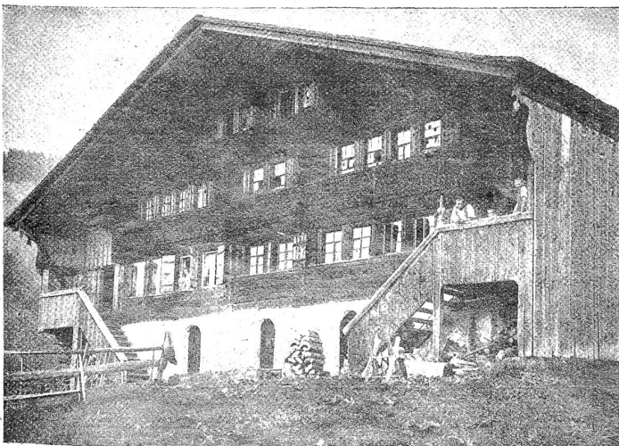
Alte Saanenhäuser. In der Biffen (erbaut 1608).
