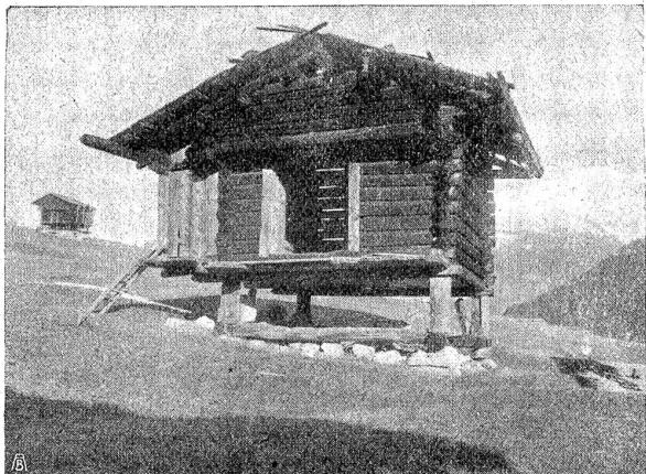
Kornspeicher auf Stelzen. (Graubünden und Wallis.)
