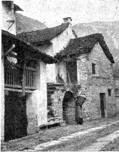
Cossiner Steinhaus mit Steinplattendach. (Cegna bei Locarno.)
