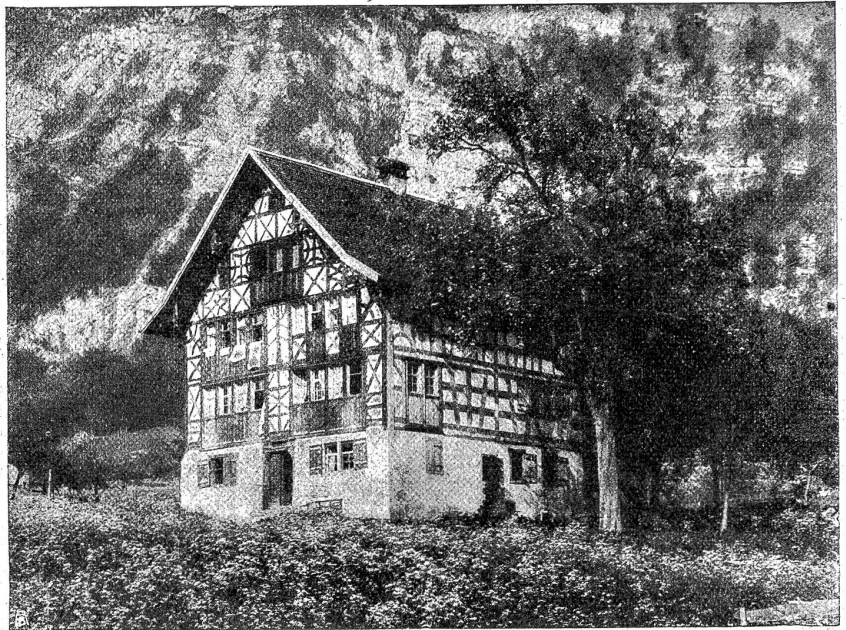
Fränkisches Haus. Fachwerk- und Riegelbau. (Netstal, Glarus.)
