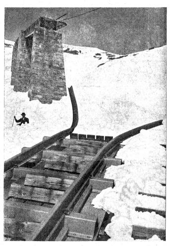
Der durch Schneerutsche eingestürzte oberste Viadukt der Riesenbahn. (Phot. G. Schneiter in Thun.)
