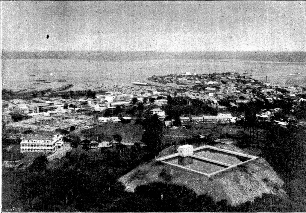
Blick in östlicher Richtung auf die Stadt und Bai von Panama vom nahen „Ancon-Hill“ aus. Im Vordergrund links das bisherige Verwaltungsgebäude der Kanalkommission, rechts neues Beton-Reservoir, zu einem Teil der städtischen Wasserversorgung gehörend. Hinter dem Verwaltungsgebäude die neue Universität von Panama.
