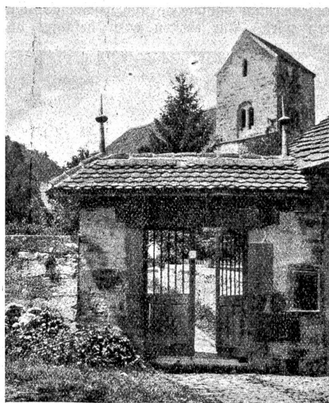
Erlach: Kirchhofeingang mit Kirchturm.
