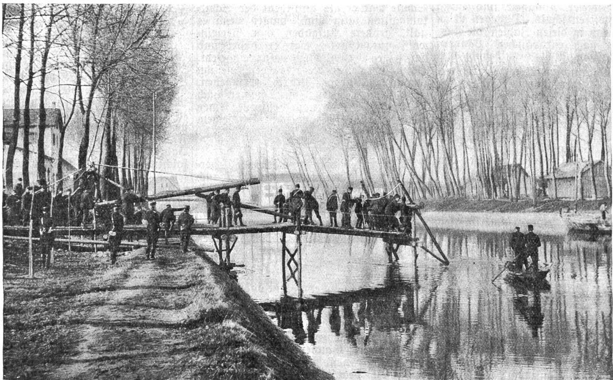
Schweizerische Militärbilder: Konstruktion einer Truppenpasserelle durch eine Genie-Abteilung.
