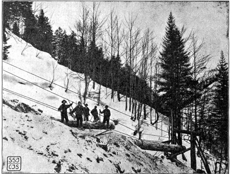
Eine sog. Seilriesen-Anlage. Mittelft des Drahtseils werden die geschlagenen Holzstämme zu Tal gefördert.
