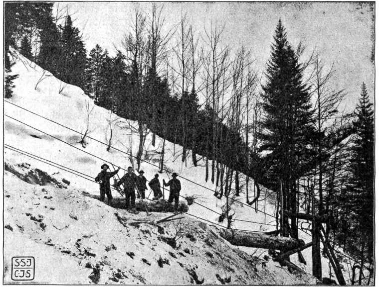
Eine sog. Seilriesen-Anlage. Mittels des Drahtseils werden die geschlagenen Holztämme zu Tal gefördert.
