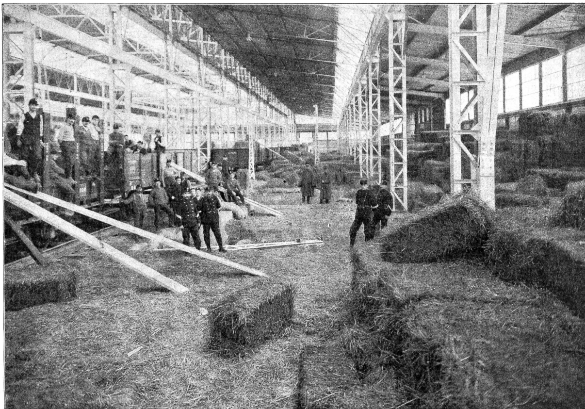
Die Maschinenhalle der Schweiz. Landesausstellung in Bern wurde f. Z. durch die Berner Alpenbahngesellschaft angekauft und sollte nach Interlaken verbracht werden als Reparaturwerkstätte. Durch die Zeitumstände veranlaßt, hat die Gesellschaft von dem Projekt abgesehen. Nun soll die in Zurzach (Aargau) gegründete Gesellschaft zur Fabrikation von Soda die Maschinenhalle angekauft haben. Gegenwärtig werden in derselben Strohvorräte für unsere Armee aufgespeichert.
