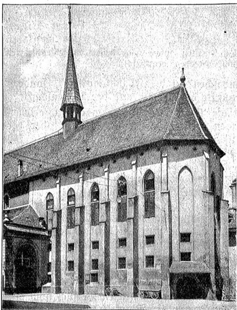
französisische Kirche: Chor vor der Restauration.
