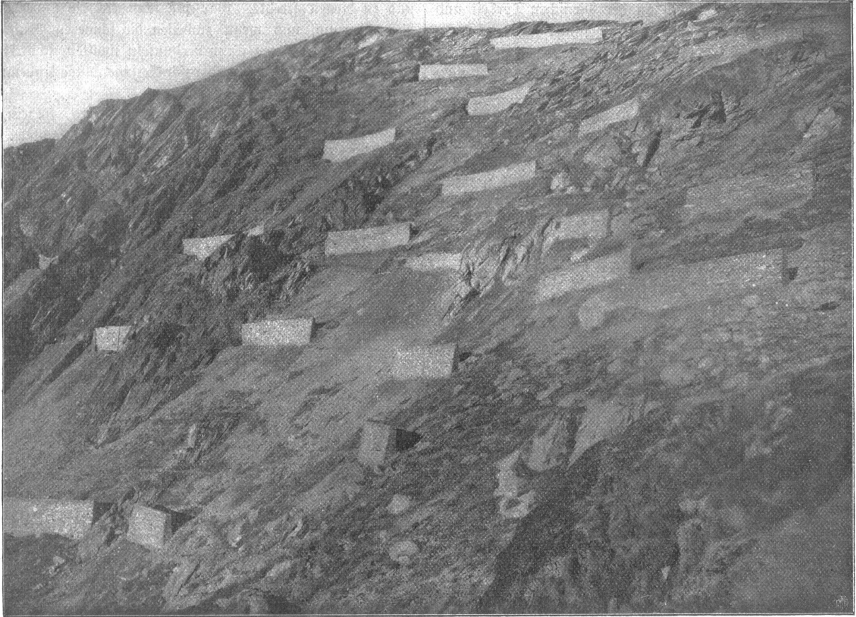
Lötschbergbahn: Die Lawinerverbauungen bei Goppenstein.
