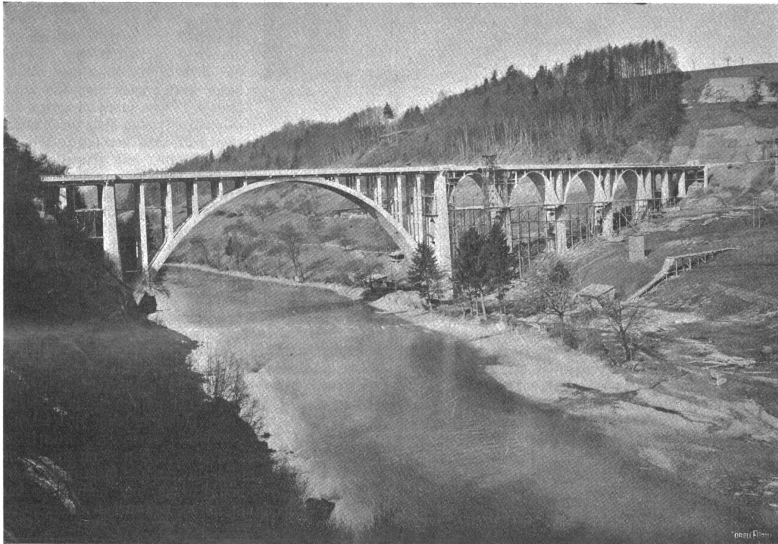
Gesamtansicht der Halenbrücke über die Aare bei Bern.
