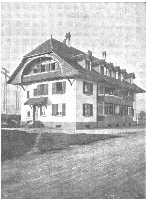
Elektrizitätswerk Kallnach. Maschinen-Wohnhaus.
