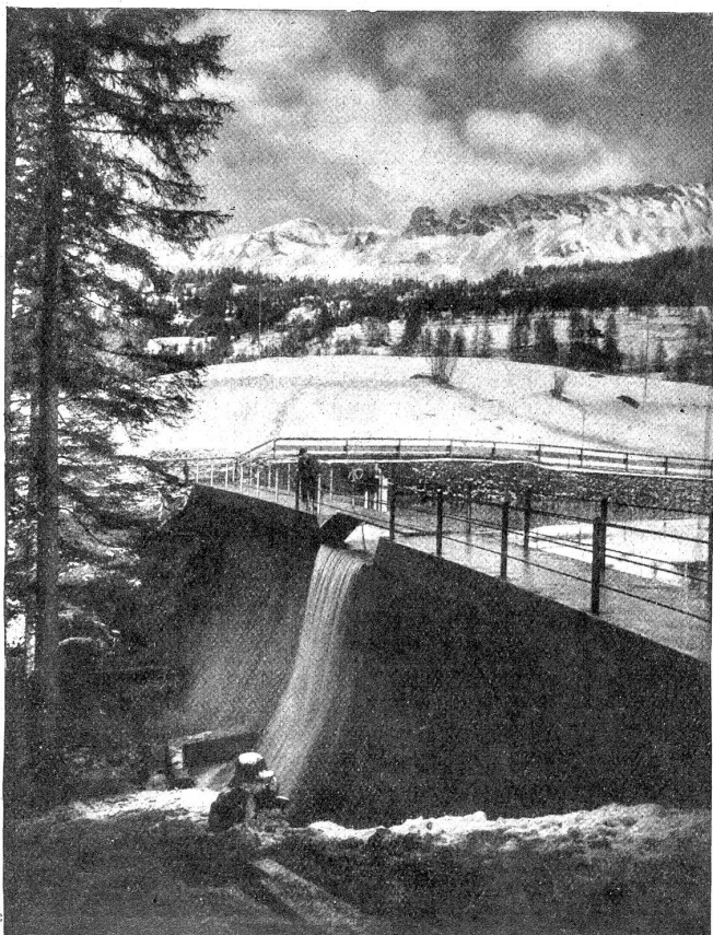
Talsperre in Churwalden: Ansicht der Staumauer von der untern Seite. Ueberfall, Bassin und Rohrleitung.
