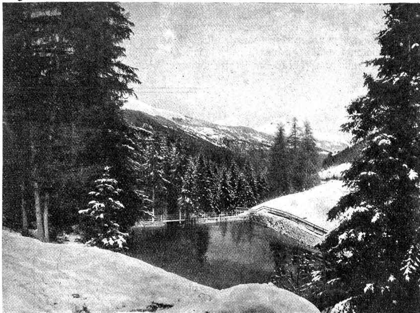
Talsperre in Churwalden: Ansicht der Staumauer von der obren Seite mit Kieschleufe und Einlaufschleufe, sowie Stauweiher mit Ueberfall.
