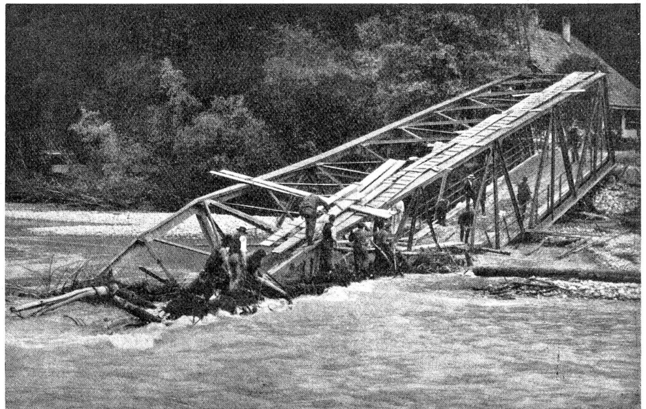
Die vom Hochwasser der Emme weggerissene Waldeggbrücke bei Burgdorf.
