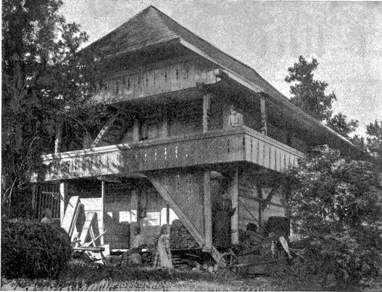
Speicher in Liebewil. An dem Feldträßchen von Köniz nach Chrishaus gelegen.
