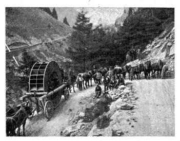
Vom Bau der Lötschbergbahn. Rad eines der großen Ventilatore zur Besorgung der Ventilation des großen Souterrains auf der Südseite des Cunnels bei Goppenstein. Schwieriger Cransport auf der Straße von Gampel nach Goppenstein.
