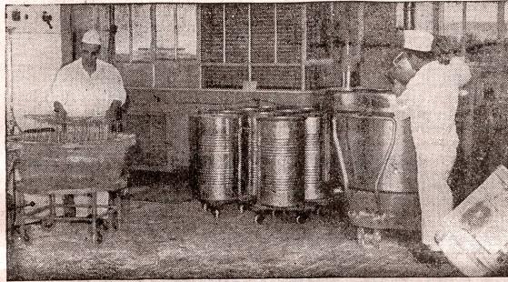
Der für die Herstellung von Tabletten benötigte Alkohol hat den Zweck, aus Wirkstoff und Hilfsstoffen — wie Stärke, Talc — zusammengestellte Pulvermasse zu granulieren und damit preßfähig zu machen. Hingegen wird er zur Gänze wieder weggetrocknet und ist im Fertigprodukt nicht mehr enthalten.
