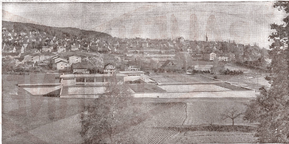
Zürichs zweites Seewasserwerk. Gesamtsituation der Filteranlage Lengg.
